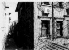
风雨楼 今淡水路丰裕里98号
