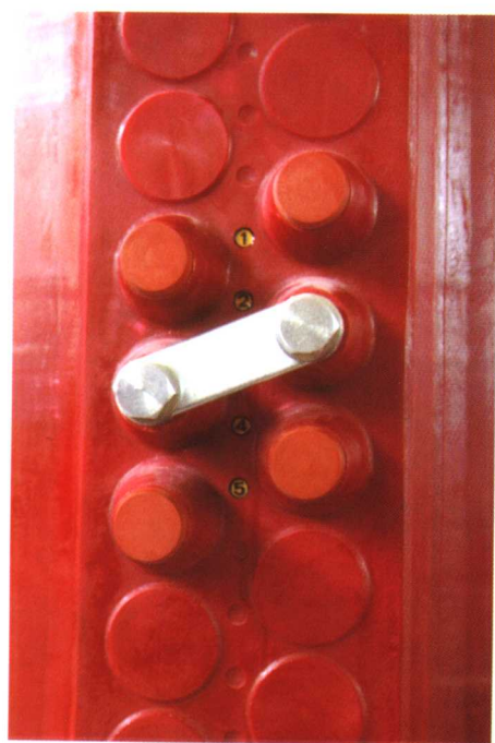
图 3-36 无励磁分接开关
