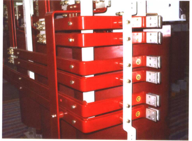
图 4-11 低压立排(双排)侧出线
