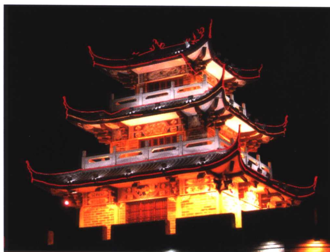
图 7 - 88 某城楼的夜间轮廓照明
