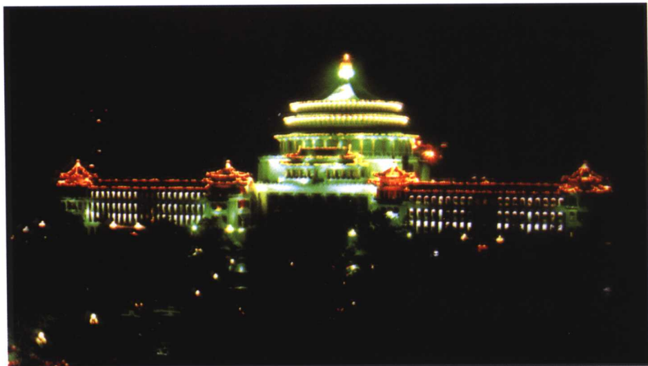
图 7 - 96 建筑立面综合夜景照明效果
