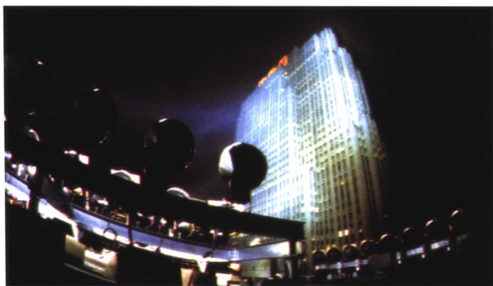
图 7 - 94 利用临近建筑放置泛光照明灯具
