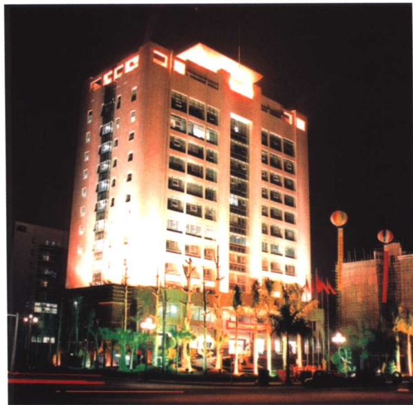
图 7 - 91 利用阳台放置泛光灯具
