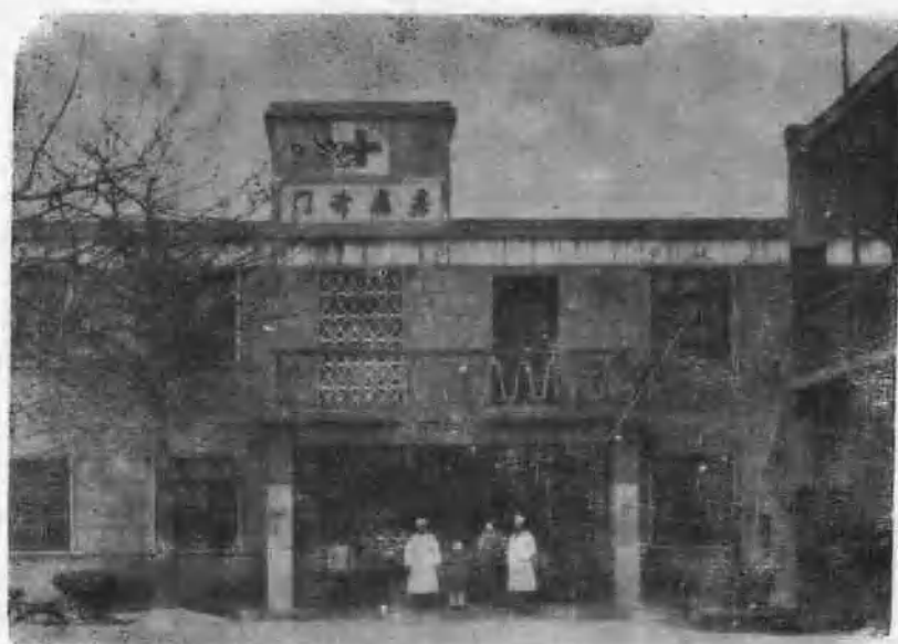
妇幼保健所门诊病房楼
