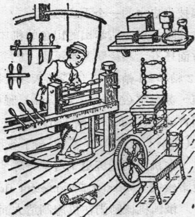
圖1 十八世紀腳踏繩索弓架傳動式車床。
