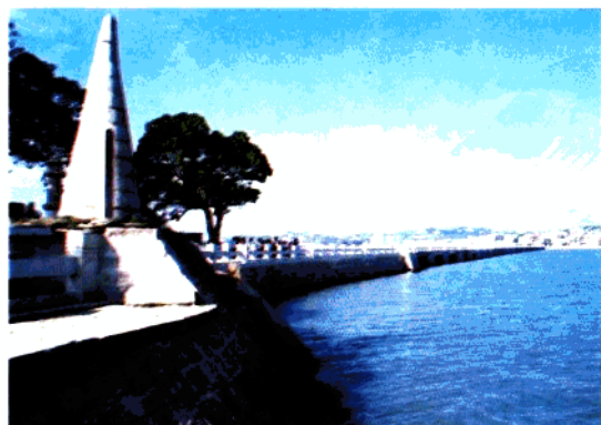
中国第一座跨海梁式石构大型桥—洛阳桥
