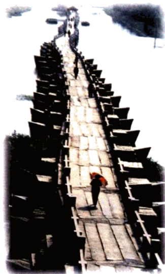
建于宋代的举世闻名的石斑跨海大桥——安平桥
