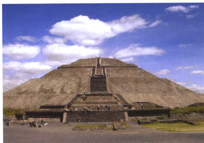
墨西哥特奥蒂瓦坎太阳金字塔
