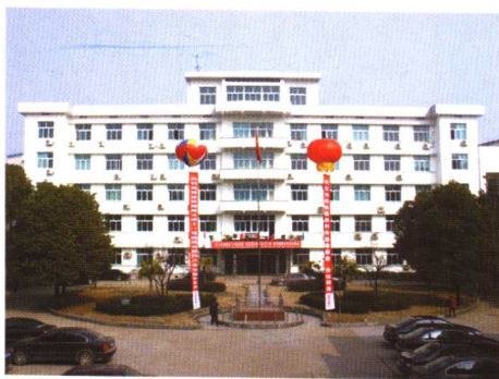
▲市人大、市政协办公大楼
