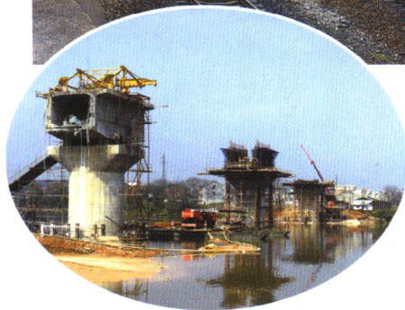
◀ 浙赣铁路复线 电气化提速改造醴陵 铁路桥施工现场
