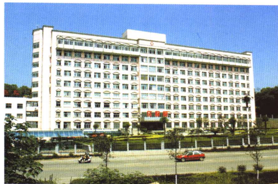
▲ 湘东医院住院大楼
