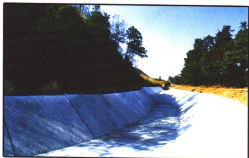
▲酒埠江灌区北干渠混凝土加固防渗工程
