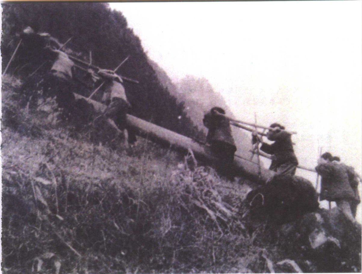
科技人员自己架设电线杆
