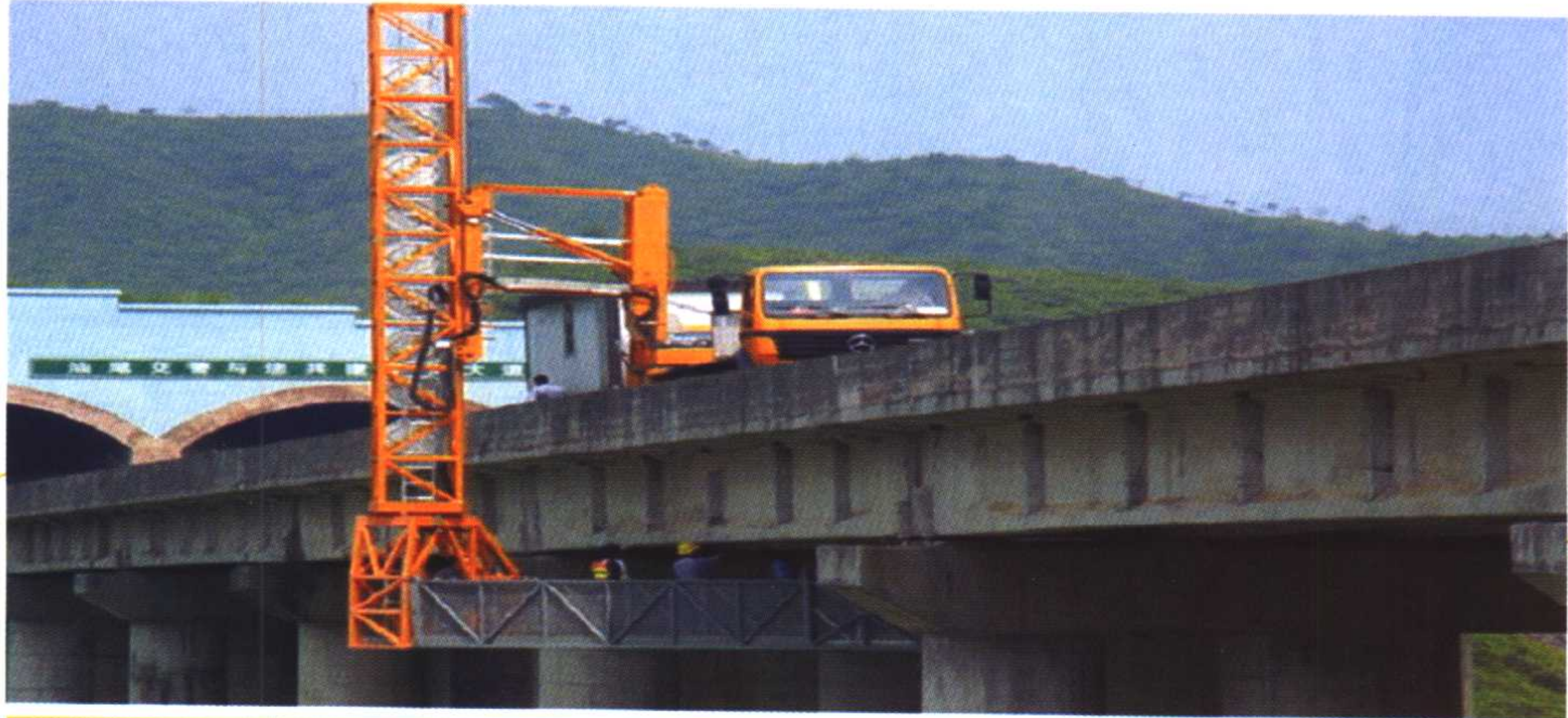
用桥梁检测专用车进行桥检作业
