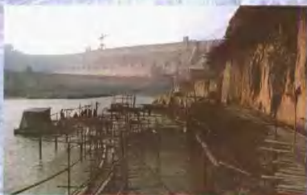
2号隧洞出口冲坑水下混凝土浇筑
