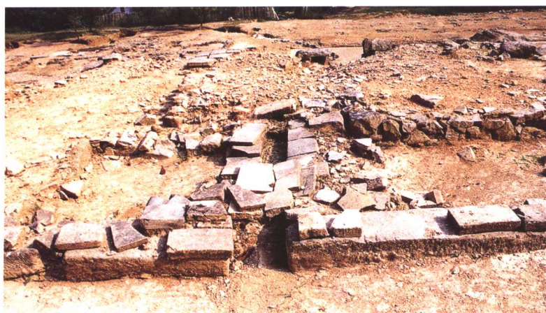
3. F2东天井出水口（自北向南）
