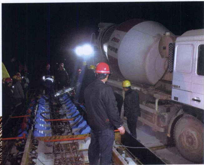
2008年2月29日 率先开始无砟轨道先行段施工
