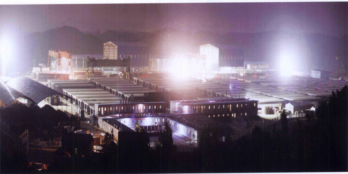
武广客运专线最大的制梁场——上水口山梁场夜景
