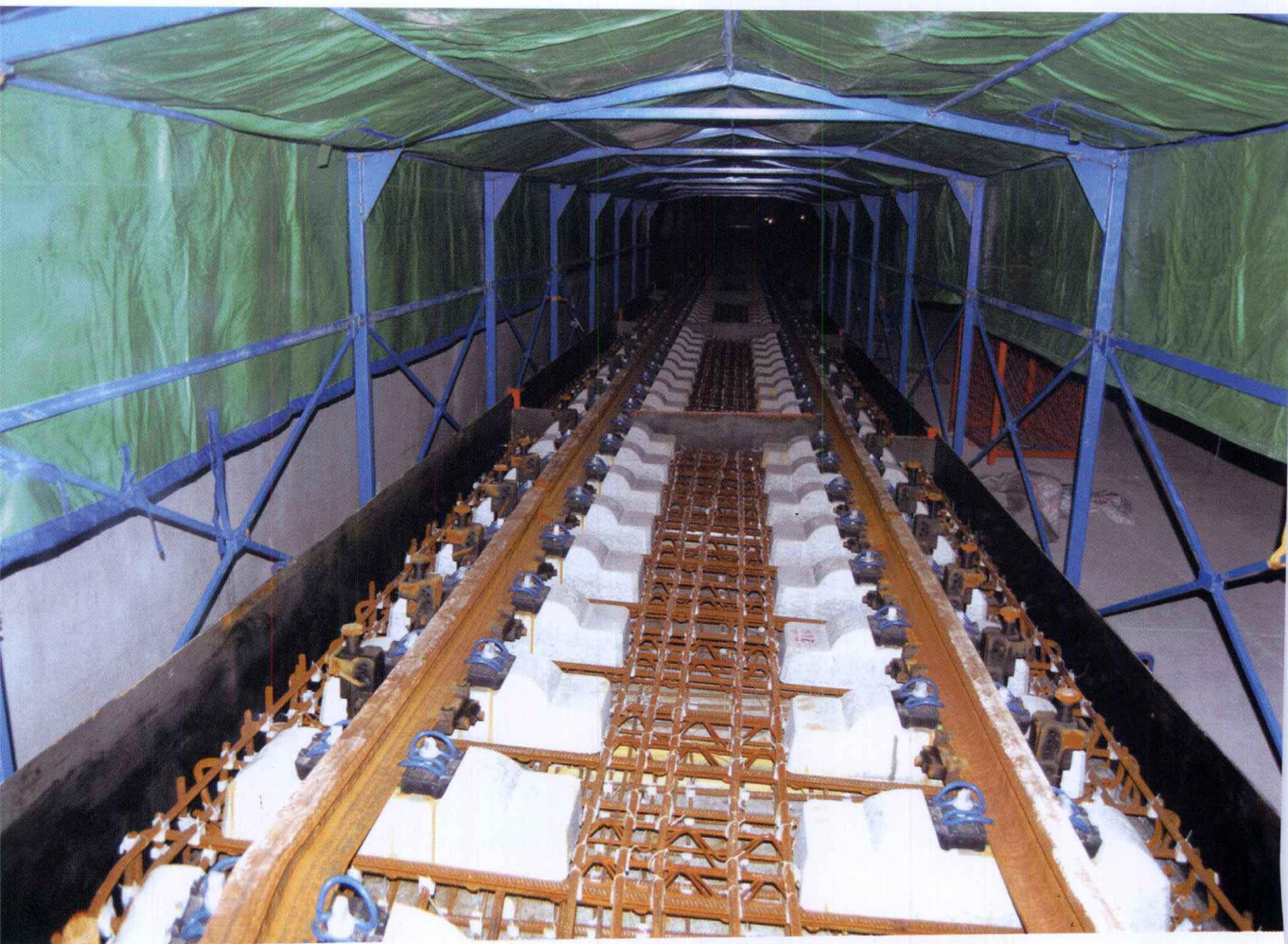
浇筑前的道床板
