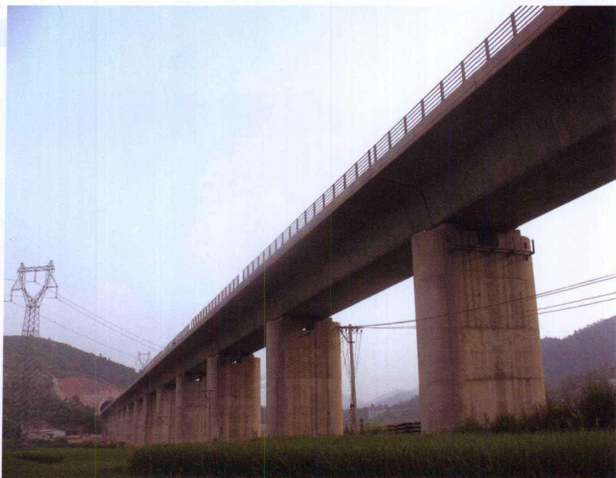
大屋坳特大桥
