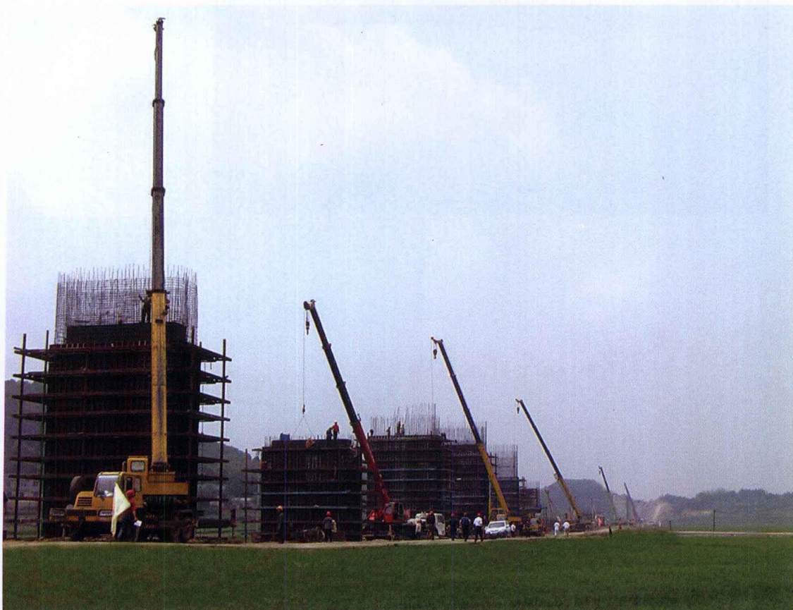
桥墩施工现场
