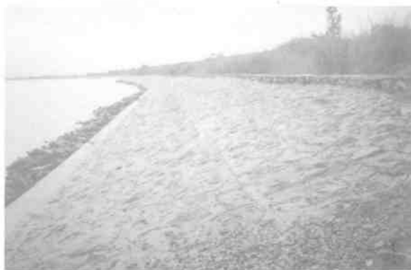
中顺大围均安镇新宁险段加固工程
