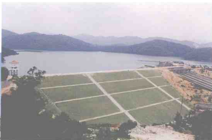
除险加固后的清城区迎咀水库
