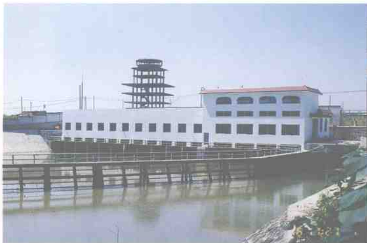
除险加固后的清城区清北电排站
