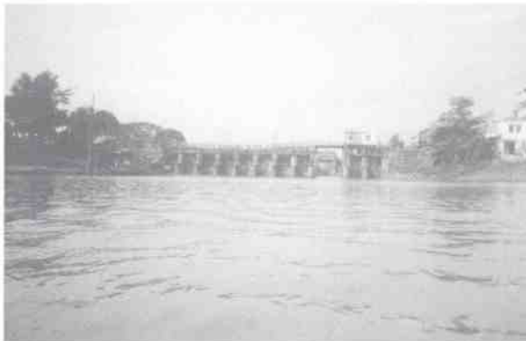
中顺大围均安镇凫洲河水闸
