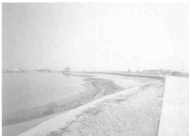
蕉桑联围顺德段龙江镇大坝险段整治现场
