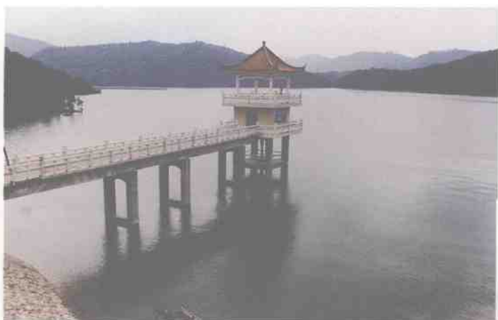
除险加固后的清城区迎咀水库
