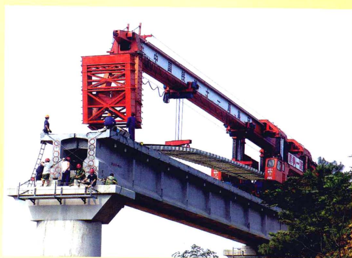
铺架机在铺轨
