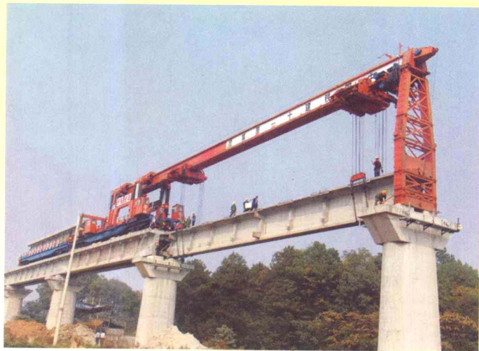
铺架机在架梁
