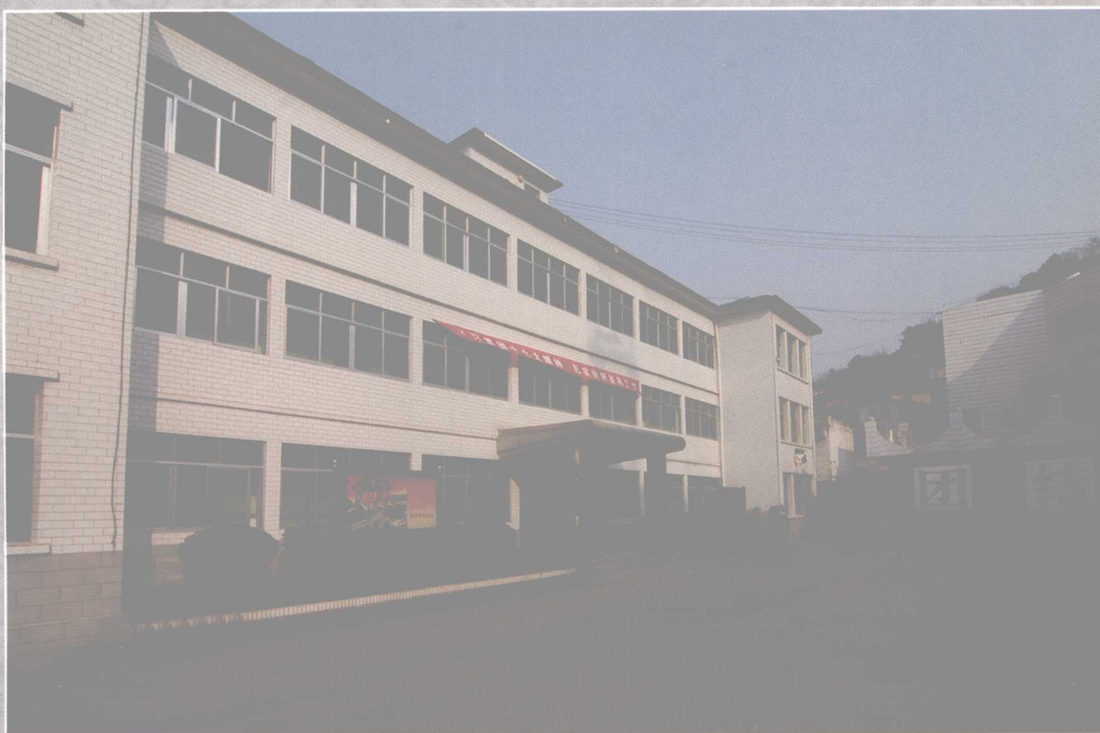
县人武部办公大楼
