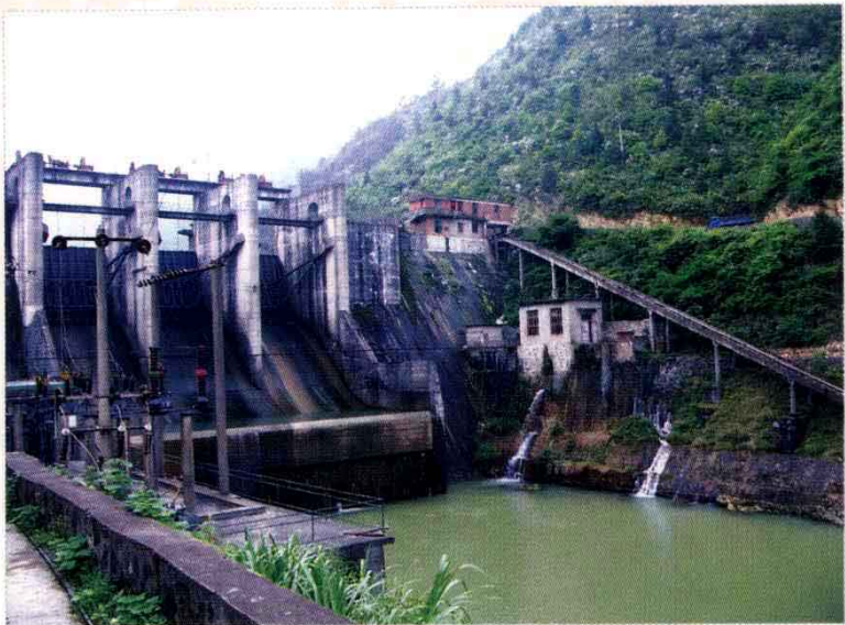
宁远县中型水库——水市水库
