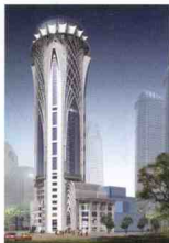
徐汇商建大厦改建 (在建项目)
