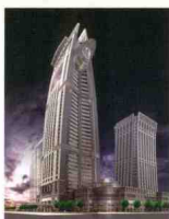
沈阳金流一号 (在建项目)
