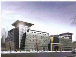
北京凯悦大酒店 (在建项目)
