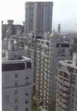
柏庐城二期 (在建项目)
