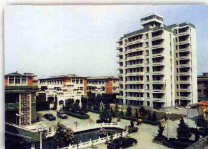
江西喜泰电机有限公司厂区
