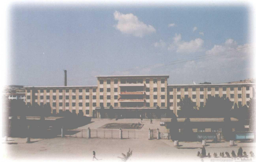
中共静乐县委、县人民政府大楼
