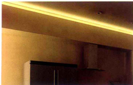
| 灯带(灯槽)照明
