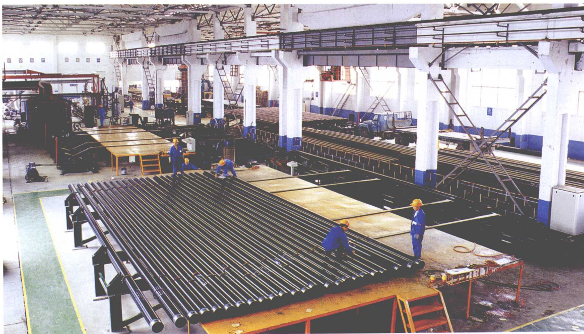
图为金洲集团 3PE 防腐钢管车间。
