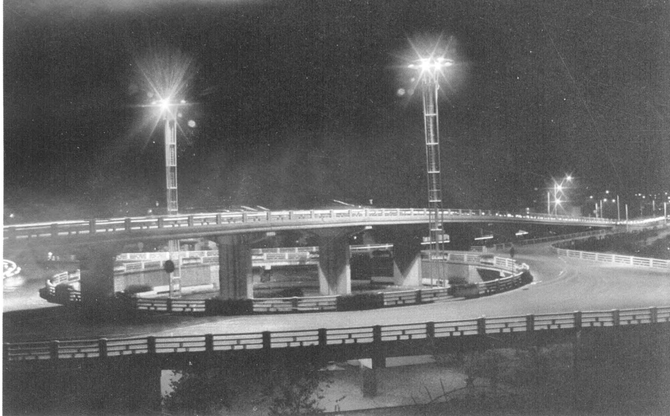
闽江桥北立交桥是福建省第一座三元立交桥，1986年 仅用 8 个月时间建成。
