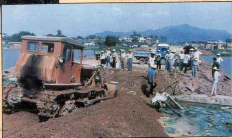
四十米宽大道正在紧张施工
