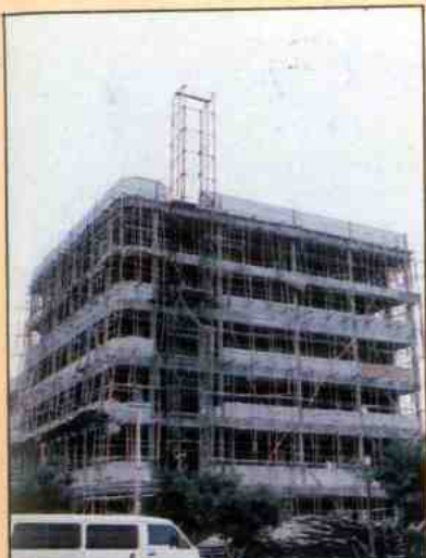
兴建中的镇企业大楼
