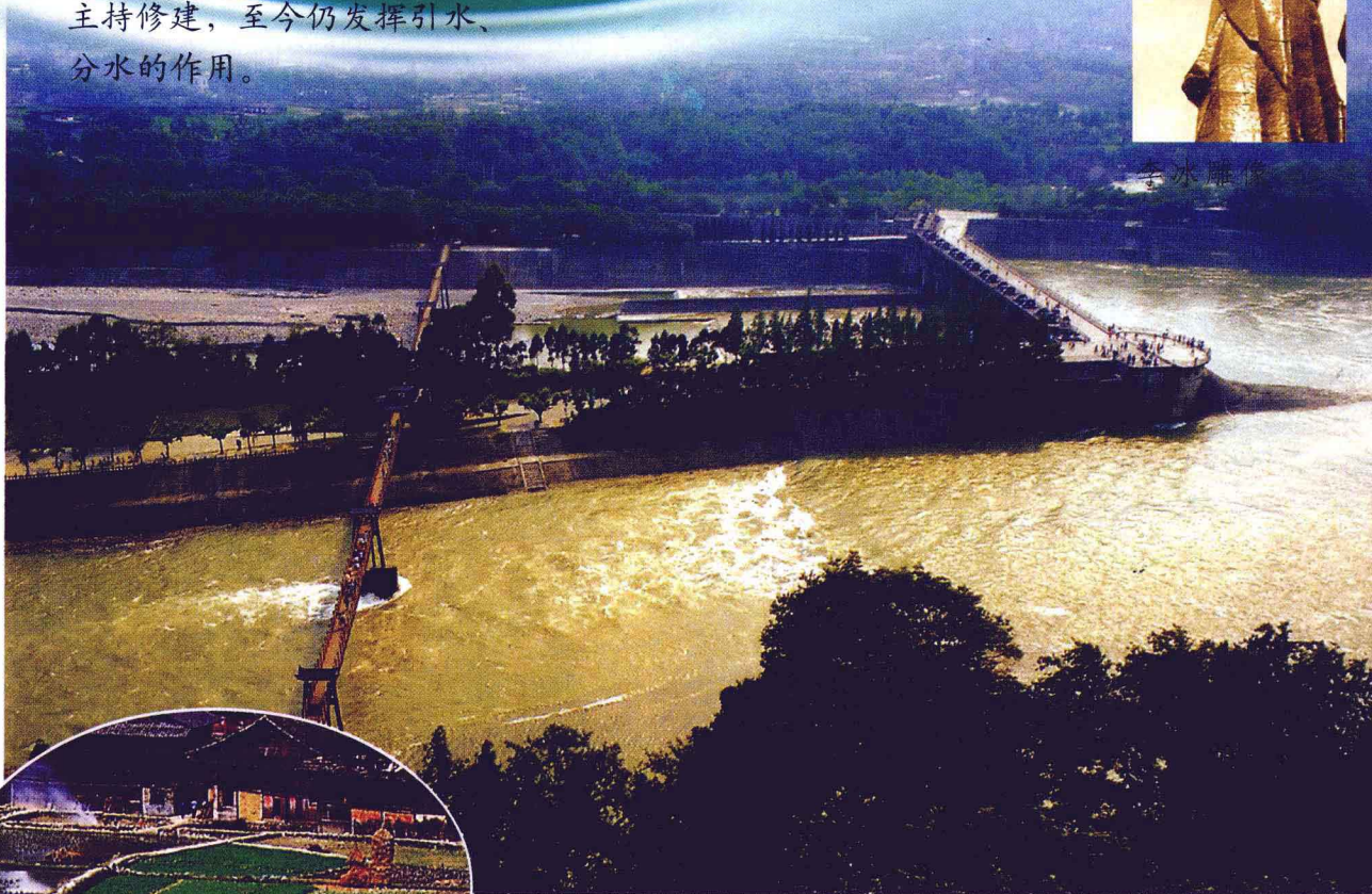
都江堰水利工程
