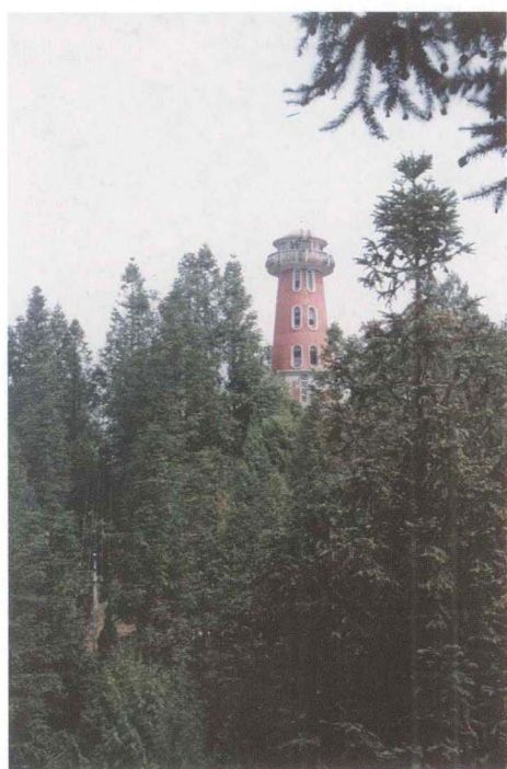
春雷林场防火瞭望塔
