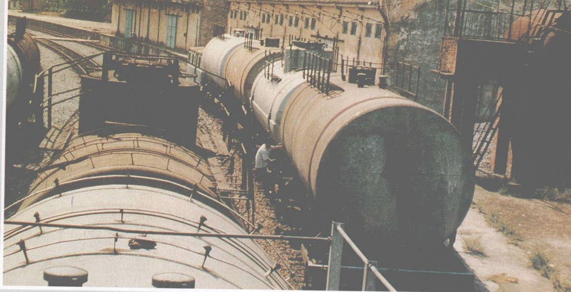
供销公司铁路专用线
