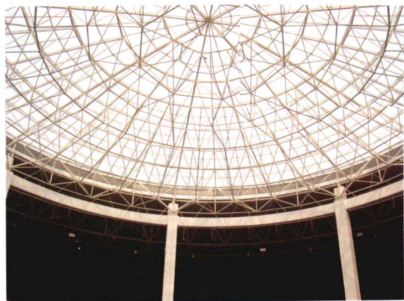
图 4.1.8 某展览大厅顶棚
