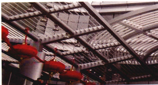
图 4.2.6 某阳光板顶棚工程
