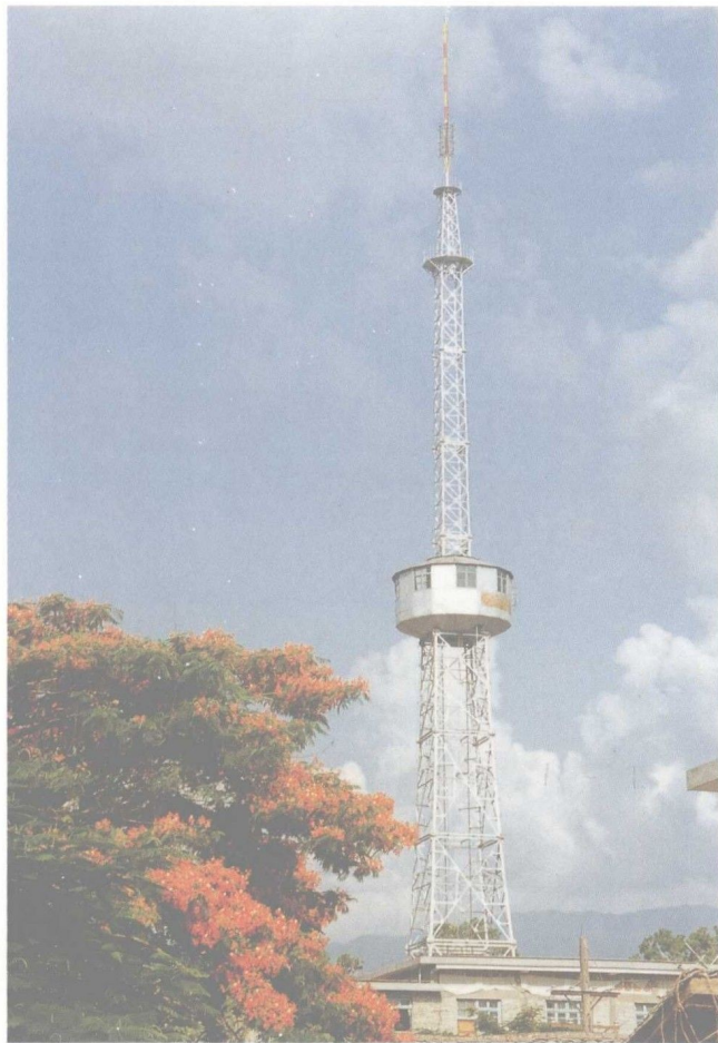
县城最高建筑——电视自立发射铁塔
