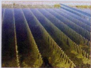
湿地塘内生物填料 Bio-filling in wetland pond
