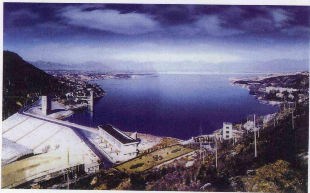
彩图 22 官厅水库库区图
