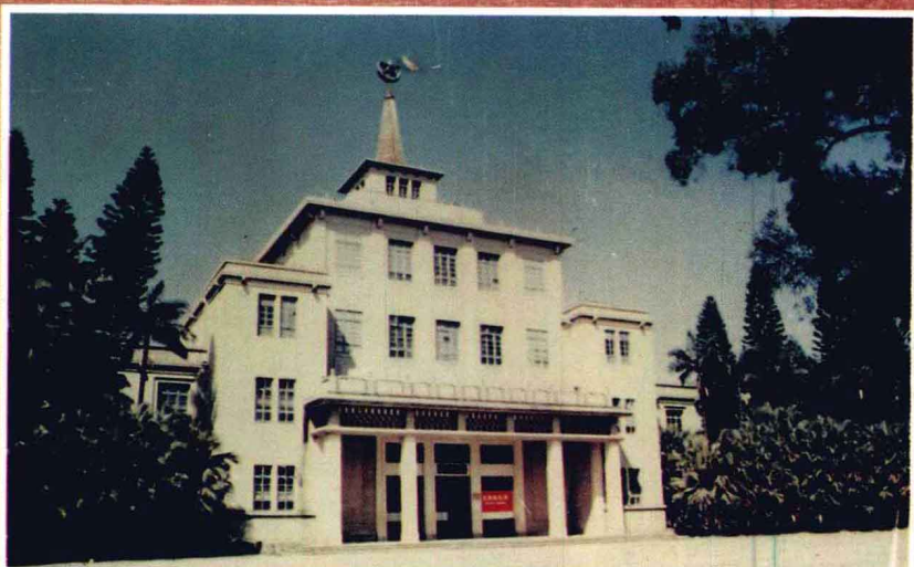
湛江市博物馆占地 3 万平方米,建筑面积 5400 平方米。 图为博物馆外景。
