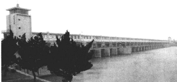
图 7 南水北调中线满城韩庄大桥
