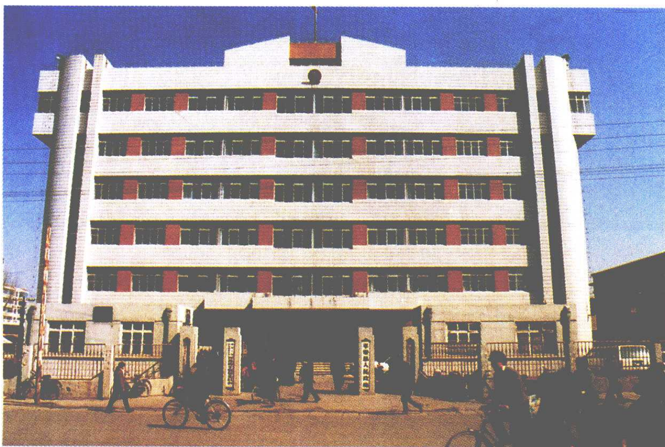
平泉县人民 政府办公楼
