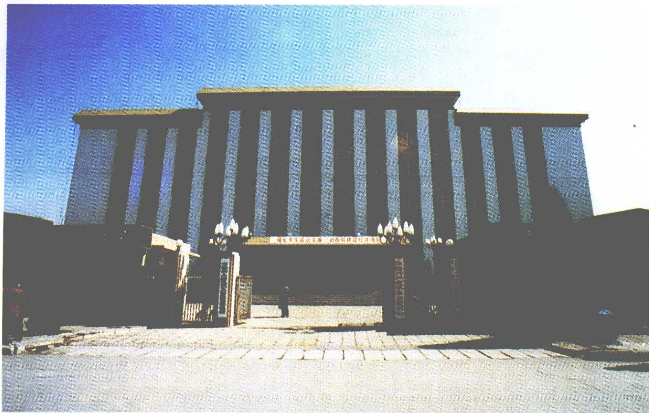
中共平泉县委、县 人大常委会办公楼
