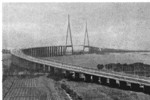
图 1-1-17 江苏苏通长江公路大桥
