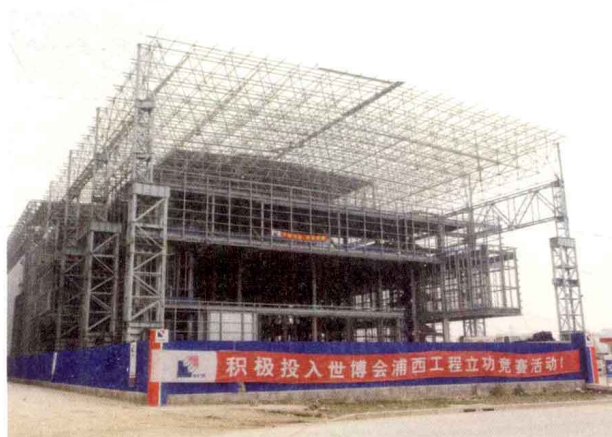
TIMAC团队在世博工地上 / “城市足迹馆”建设中
