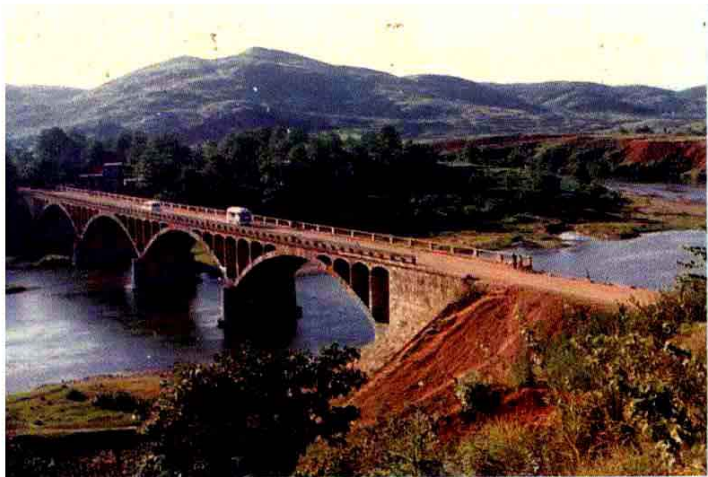
▲横跨钟水的茂林公路桥
