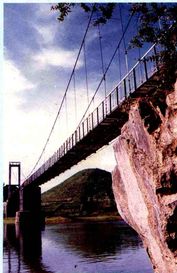
▲钟水河上的黄甲吊桥
