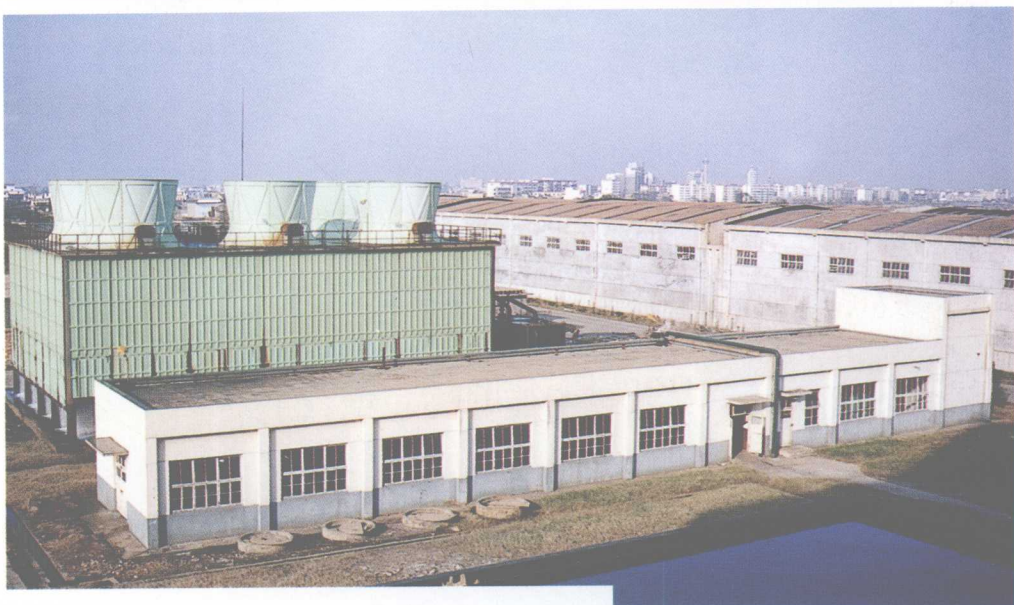
江西盐矿盐硝 分厂循环水泵房
