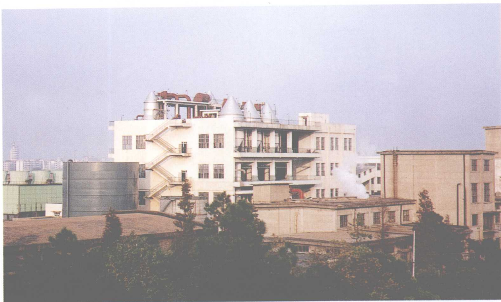
江西盐矿 30 万 吨井冈牌精制碘盐 主体工程
