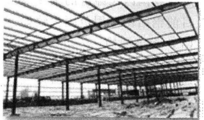
图 1.2.5 轻钢工业厂房门式刚架
