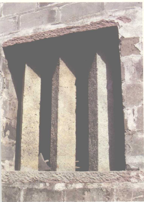
↑图1.1 鄞州走马塘村的三直棍柱石窗，三条粗壮有力的直棍柱很好地满足了石窗防盗功能
