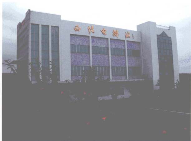
佛山市三水区白坭电排站。
