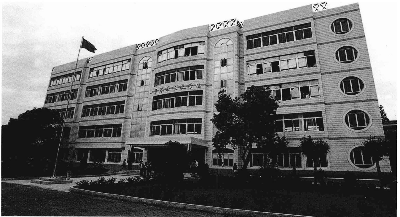
△1998年10月竣工的奉化二中甬港联谊教学楼
