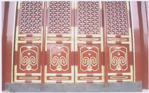
彩图5-1-8 框线及隔扇云盘线、面叶、绦环线、菱花扣贴金
