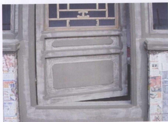
彩图3-4-3 槛框、踏板、门扇轧线、找细灰
