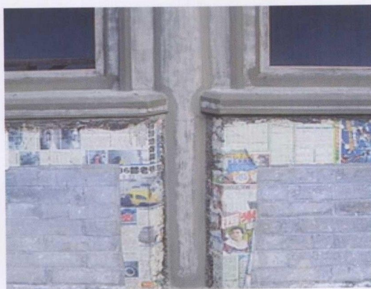
彩图3-4-4 柱框、踏板轧线、找细灰
