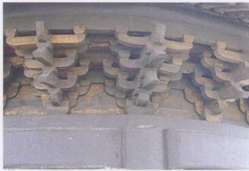
彩图3-7-4 斗拱捉缝灰、上架大木通灰
