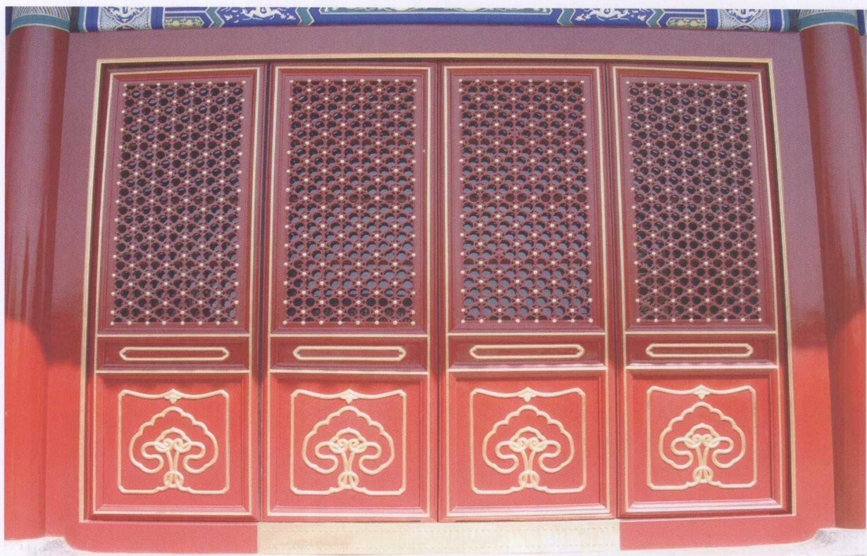
彩图5-1-2 框线、云盘线、绦环线、柱香、菱花扣贴金
