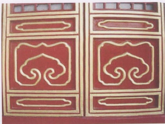
彩图5-1-12 隔扇皮条线、云盘线、绦环线贴金
