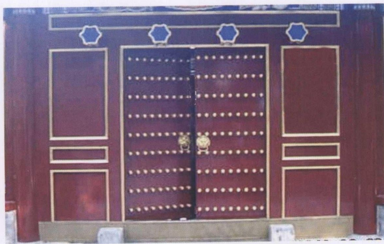
彩图5-1-14 框线、门钉、兽面门钹、门簪边贴金
