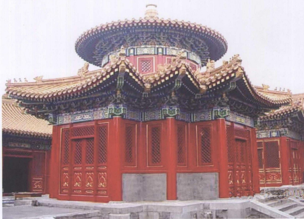
油饰彩画竣工工程
