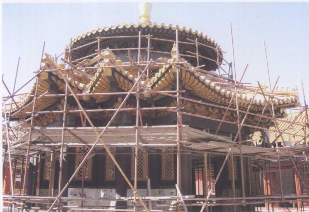
古建地仗工程施工中
