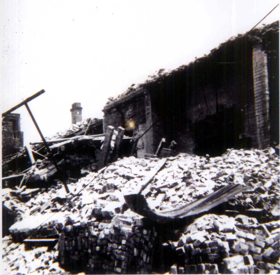
(六)1938年10月21日广州沦陷,沦陷前日机狂轰滥炸。图为日机轰炸黄沙时成废墟的惨状。
