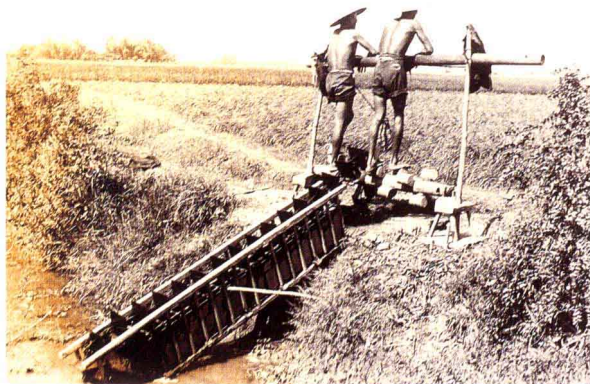
缺乏水圳灌溉的地區，農民以人力取水。圖為清代普見的龍骨車，以腳踏方式將低水吸往高地。
