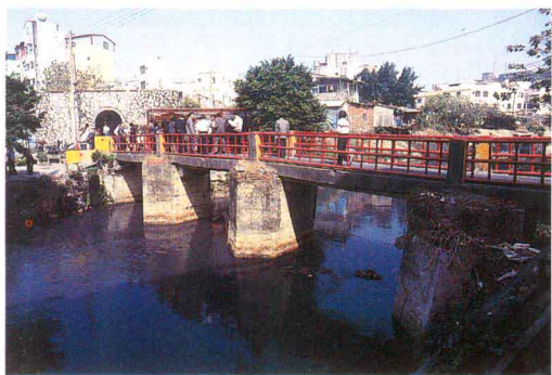
(上) 高雄左營鳳山舊城東門外的城壕，內外架設石樑橋；橋墩作船首形，稱為分水尖，惜近年因防洪而被拆。
