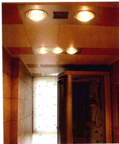
图1-6 某浴室顶部的换气、取暖和照明布置
