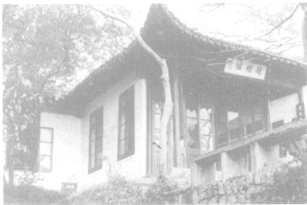
此题襟馆又名“隐闲楼”，原为昌硕先生在杭居所，位于西泠印社。
