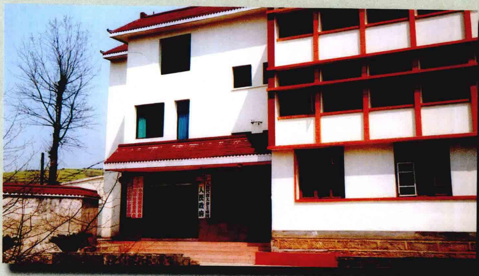
小寨坝镇党政办公楼
