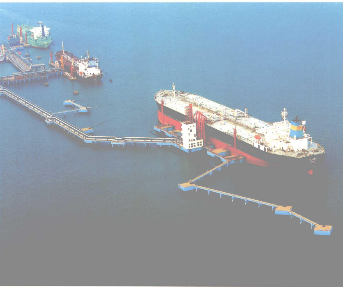
华南第一座30万吨级陆岸油码头——湛江港30万吨级油码头
