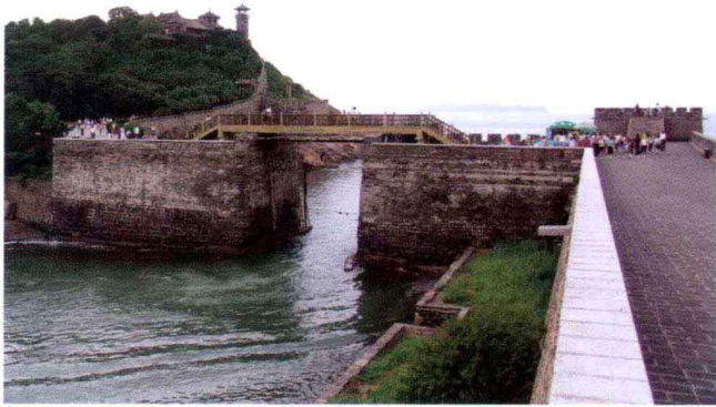
山东蓬莱水闸
