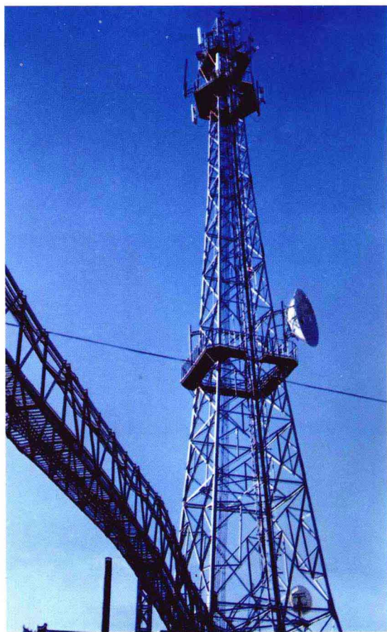
▲ 电信微波铁塔
